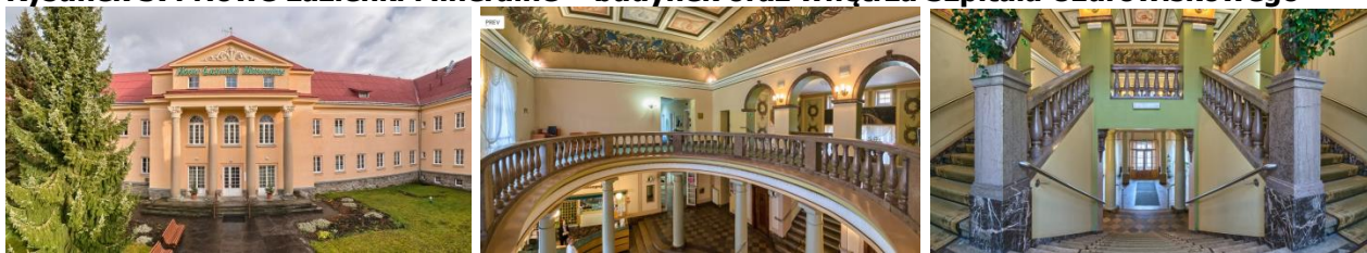
Rysunek 37. Nowe Łazienki Mineralne – budynek oraz wnętrza Szpitala Uzdrawiskowego
