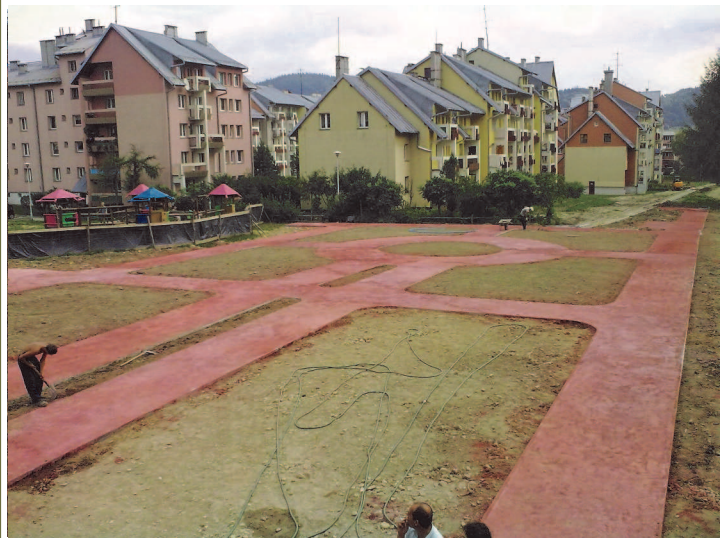
Prace przy budowie parku - miasteczko rowerowe
