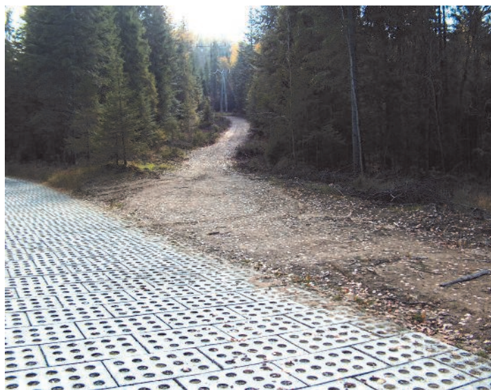
Trasa wzdłuż linii energetycznej na Górze Parkowej
