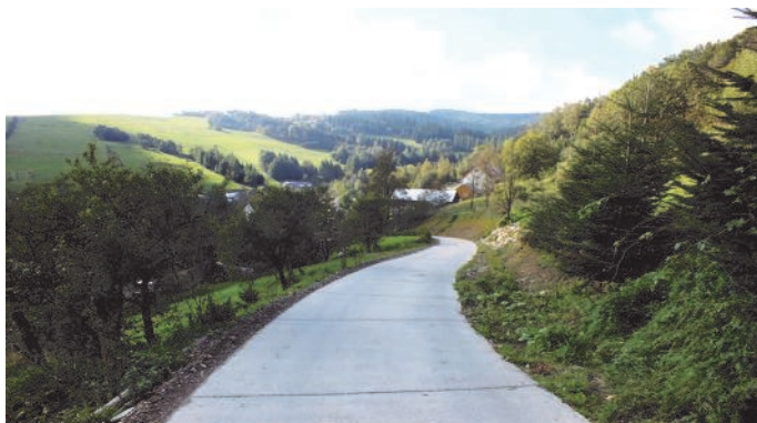
61. Budowa drogi betonowej w Bereście
