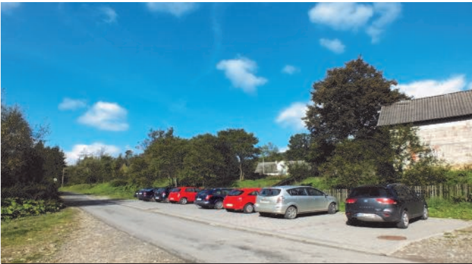
65. Budowa placu parkingowego przy Szkole w Bereście
