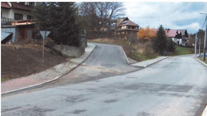
29. Remont drogi do Osiedla I przy Starej Drodze
