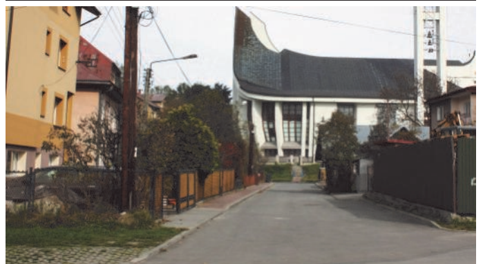
20. Remont ulicy Granicznej
