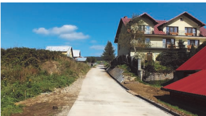
101. Droga betonowa w Tylicz
