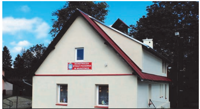
88. Remont budynku remizy OSP w Muszynie
