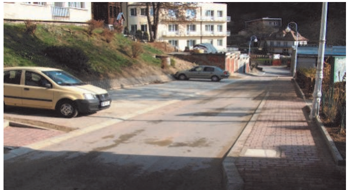
38. Remont ulicy na osiedlu Tysiąclecia
