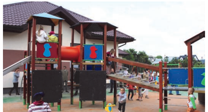
96. Budowa placu zabaw w Pioruniec
