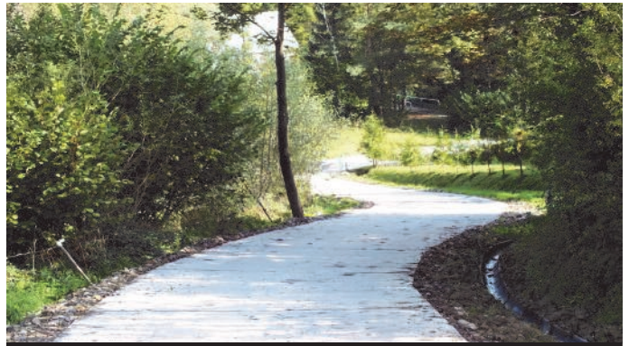
64. Budowa drogi betonowej w Bereście
