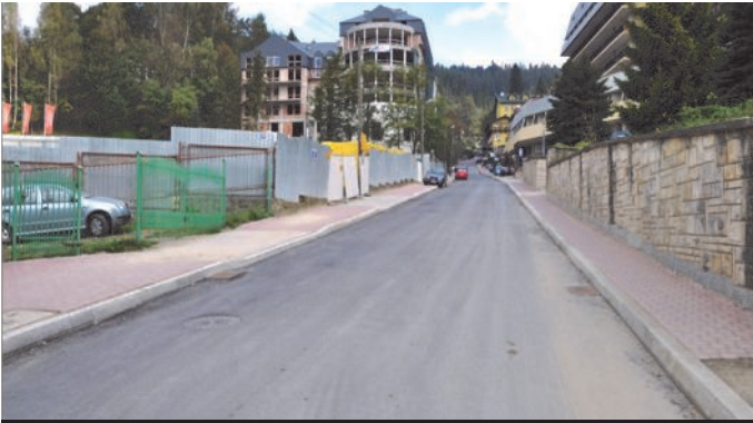
33. Odbudowa ulicy Świdzińskiego
