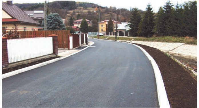
24. Remont nawierzchni ulicy Krótkiej
