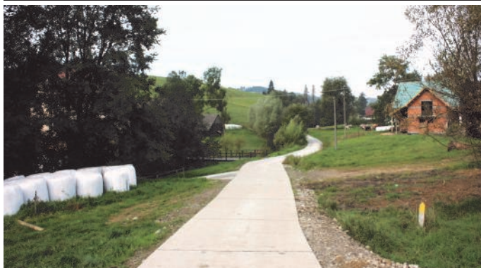
77. Droga betonowa w Mochnaczcze Niżnej
