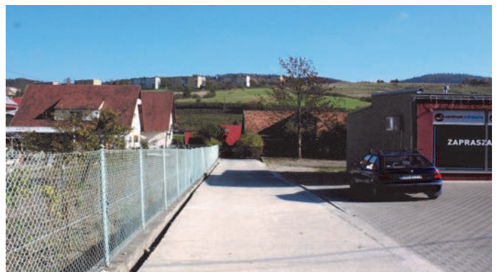
32. Remont nawierzchni przy ulicy Kraszewskiego
