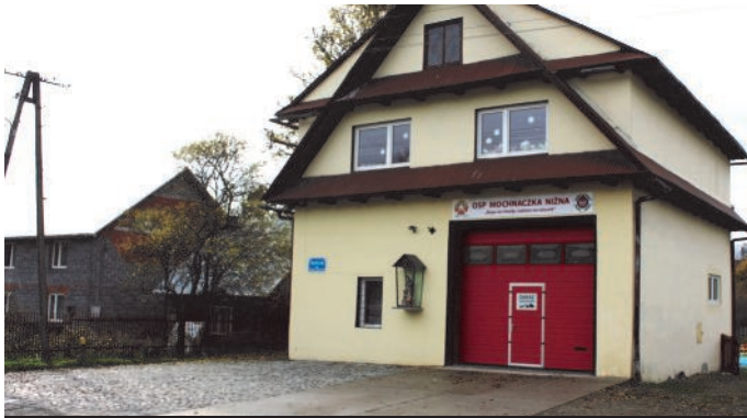
83. Remont budynku i podjazdu OSP w Mochnaczce Niżnej
