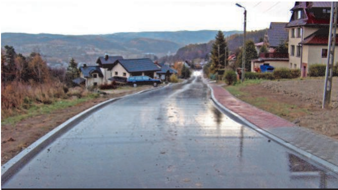
15. Remont nawierzchni ulicy Zamkowej
