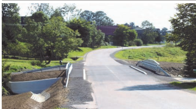
78. Przebudowa mostów w Mochnaczcce Niżnej i Wyżnej
