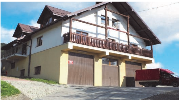
67. Wykonanie podjazdu do budynku OSP w Bereście
