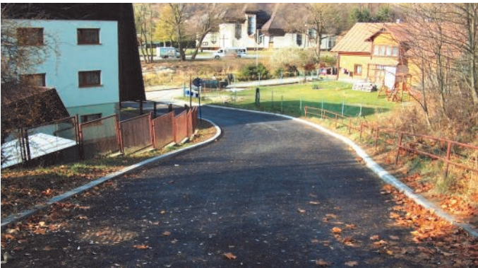
37. Remont ulicy Jaworowej
