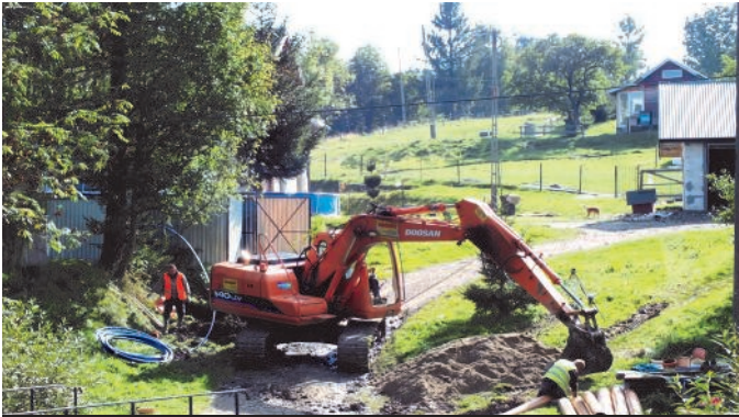
93. Budowa kanalizacji i wodociągu w Pioruniec i Czornej
