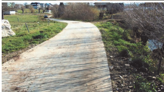
82. Droga betonowa w Mochnaczcze Niżnej
