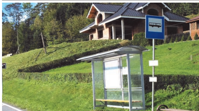
60. Nowa wiata przystankowa w Bereście
