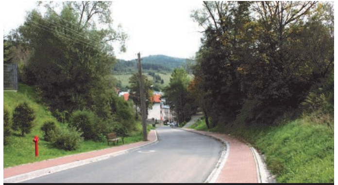
26. Remont nawierzchni ulicy Polnej
