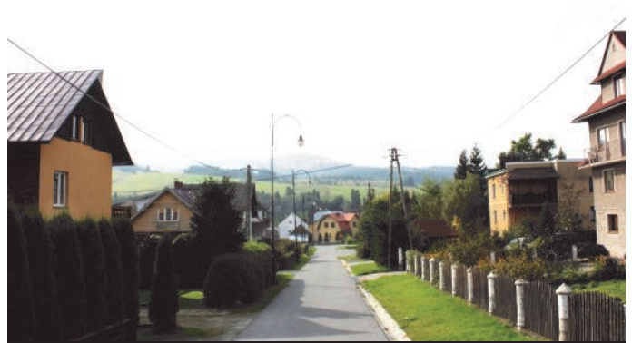
104. Remont ulicy Bocznej w Tyliczu
