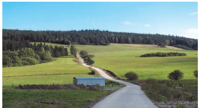
92. Budowa drogi asfaltowej w Pioruncie
