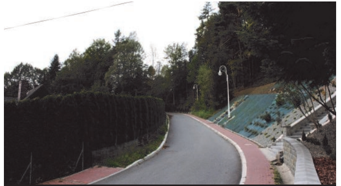
16. Remont nawierzchni ulicy Wysokiej
