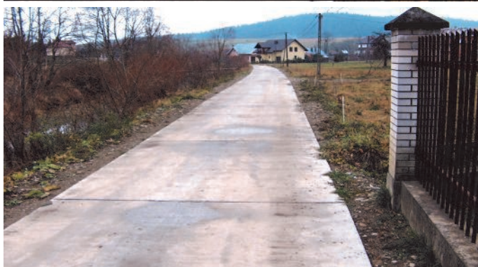
81. Droga betonowa w Mochnaczcze Niżnej
