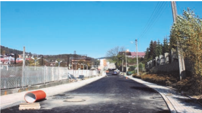
35. Remont ulicy Słonecznej
