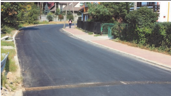
19. Remont ulicy Granicznej
