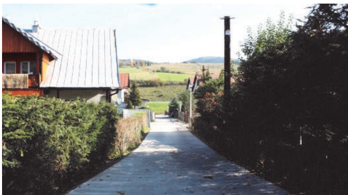
31. Remont nawierzchni przy ulicy Kraszewskiego
