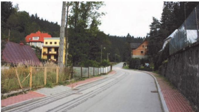
17. Odbudowa ulicy Leśnej
