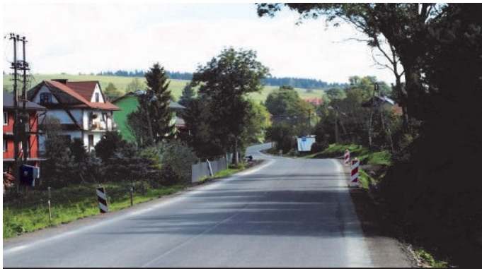
87. Remont nawierzchni drogi krajowej w Muszynie
