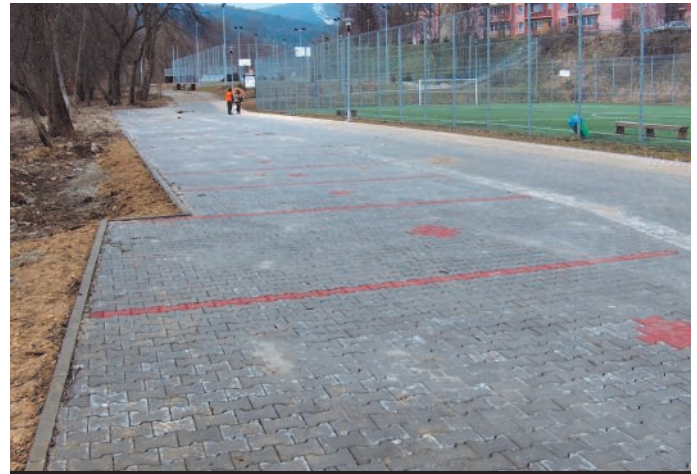
8. Parking przy parku sportowo-rekreacyjnym
