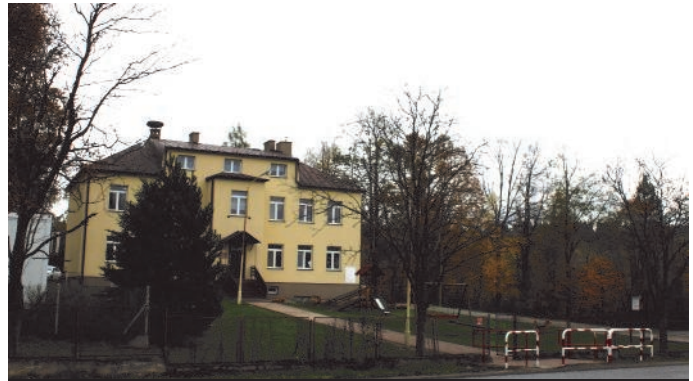
84. Remont chodnika przy szkole w Mochnaczce Niżnej
