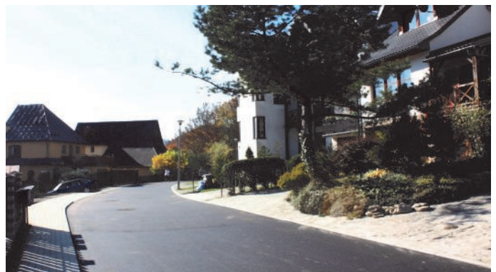
30. Remont drogi do Osiedla II przy Starej Drodze
