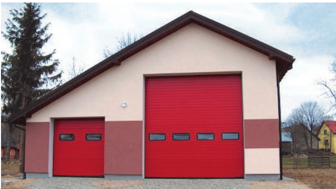
95. Budowa garażu dla potrzeb OSP w Pioruniec
