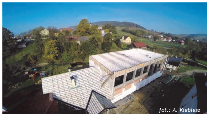
112. Budowa Sali gimnastycznej w Tyliczu
