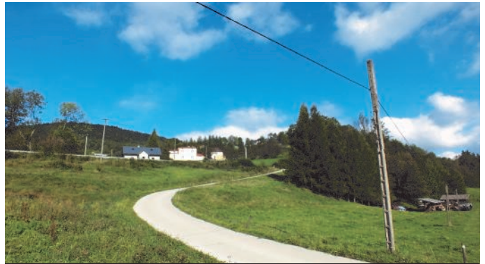
66. Remont drogi w Bereście
