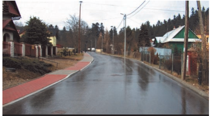
14. Odbudowa ulicy Stara Droga
