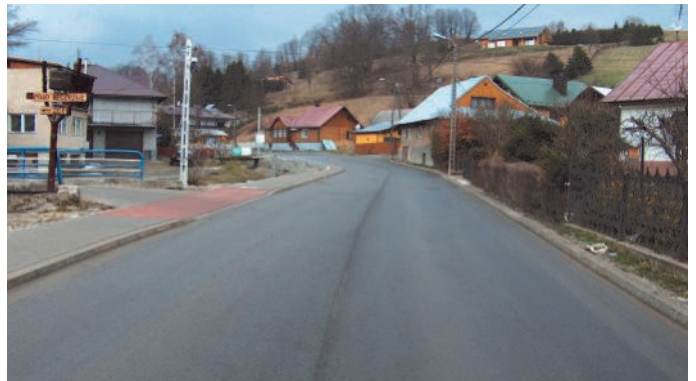
28. Odbudowa ulicy Słotwińskiej
