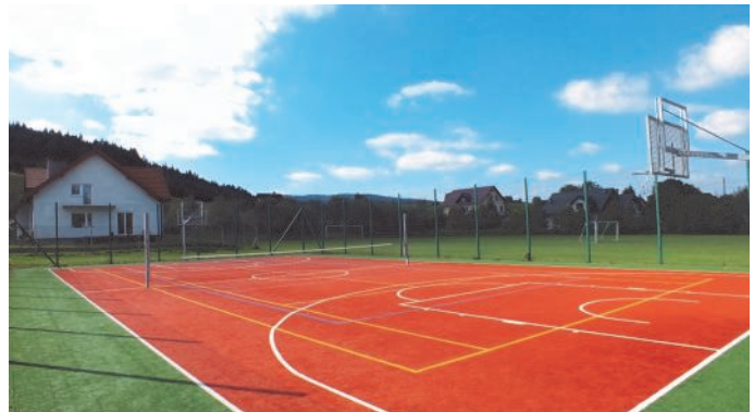
90. Budowa boiska wielofunkcyjnego w Muszynie
