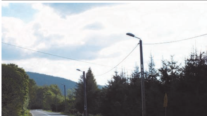
59. Wykonanie oświetlenia ulicznego w Bereście
