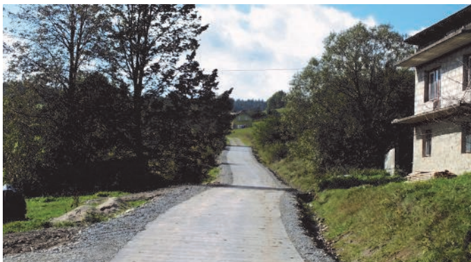
91. Budowa drogi betonowej w Pioruncie
