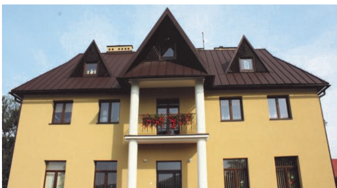
109. Remont budynku Domu Kultury w Tyliczu
