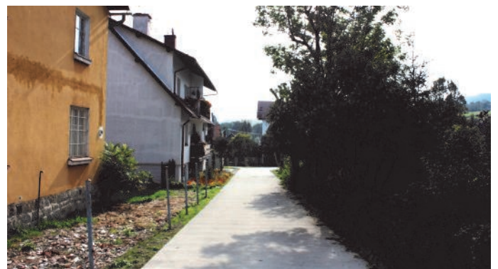
102. Droga betonowa w Tylicz
