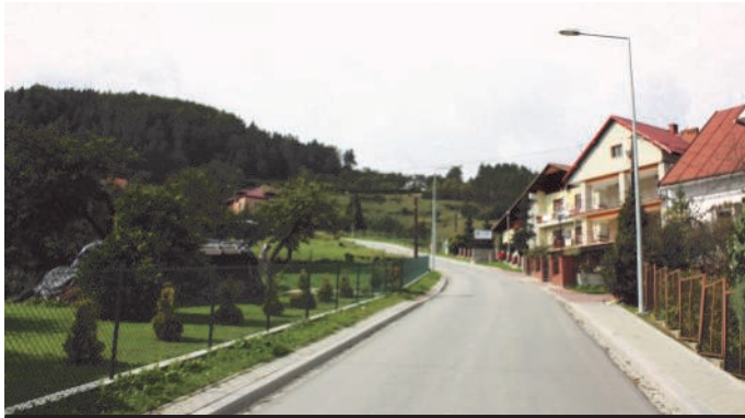
25. Remont nawierzchni ulicy Halnej
