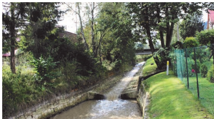
54. Remont i czyszczenie koryta Czarnego Potoku
