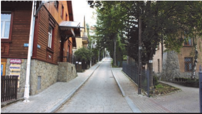
13. Remont nawierzchni ulicy Kościelnej
