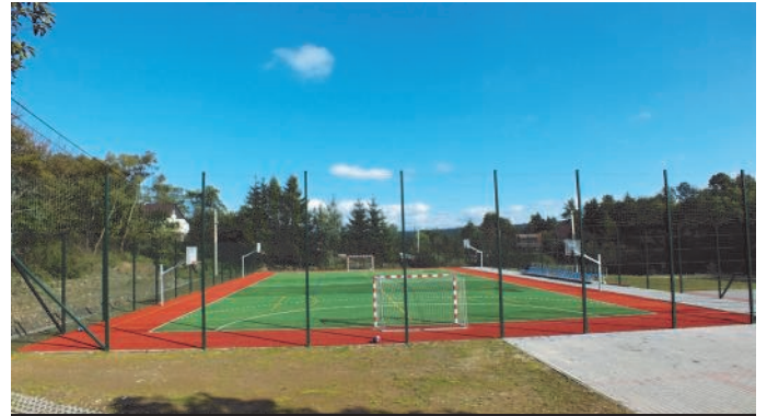
94. Budowa boiska wielofunkcyjnego w Pioruniec
