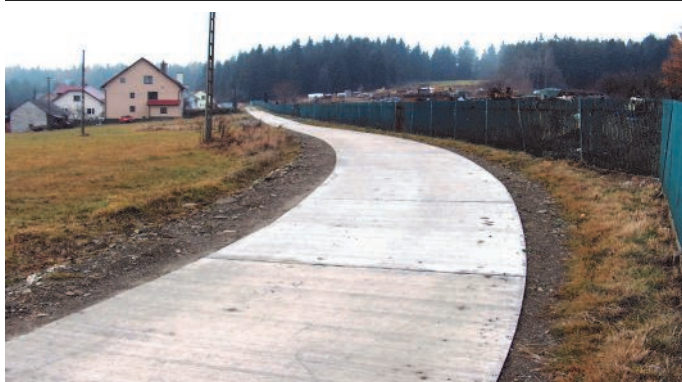
79. Droga betonowa w Mochnaczcze Wyżnej
