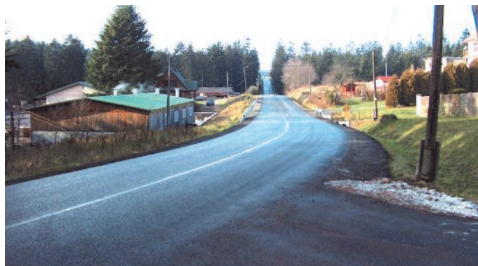
74. Remont drogi krajowej w Mochnaczcze Wyżnej
