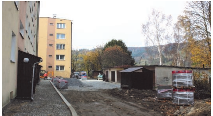
36. Remont drogi dojazdowej na osiedlu Źródłana
