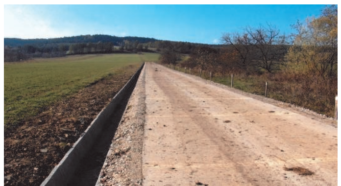
72. Budowa drogi betonowej w Czirnej
